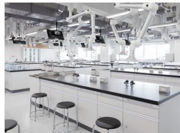
4号館実験室：可動式のアームダクト、ドラフトチャンバーなど設備が充実。1・2年生の実験授業で使用。
